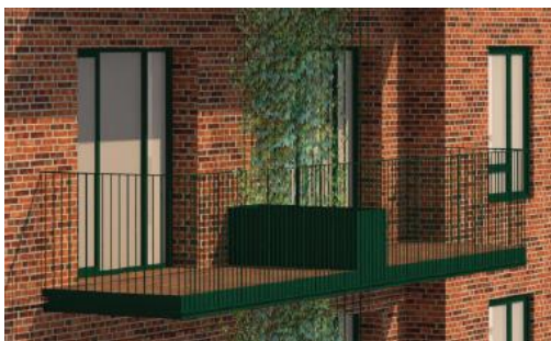
Eksempel på dobbeltaltan med grøn afskærmning med grønne lodrette balustre
